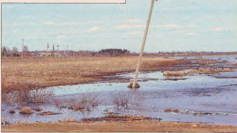
Столб линии электропередачи утонул в воде и сильно накренился.
