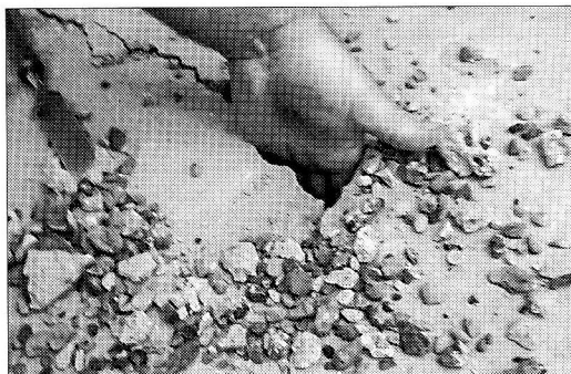
Неприятный сюрприз – из-за таких расщелин наливной пол сделать невозможно ►
