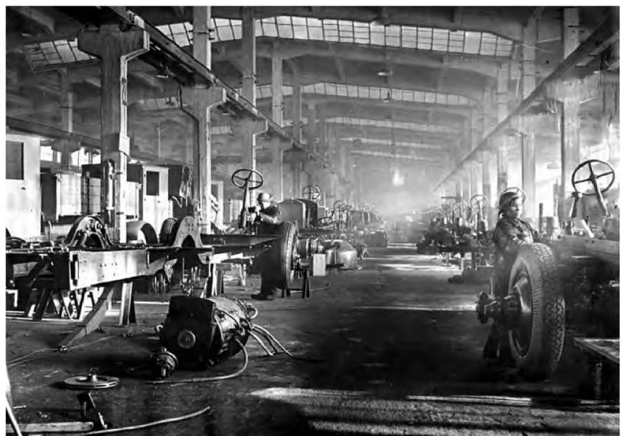
Сборка опытного ЯТБ-1 на заводе. 1936 год
