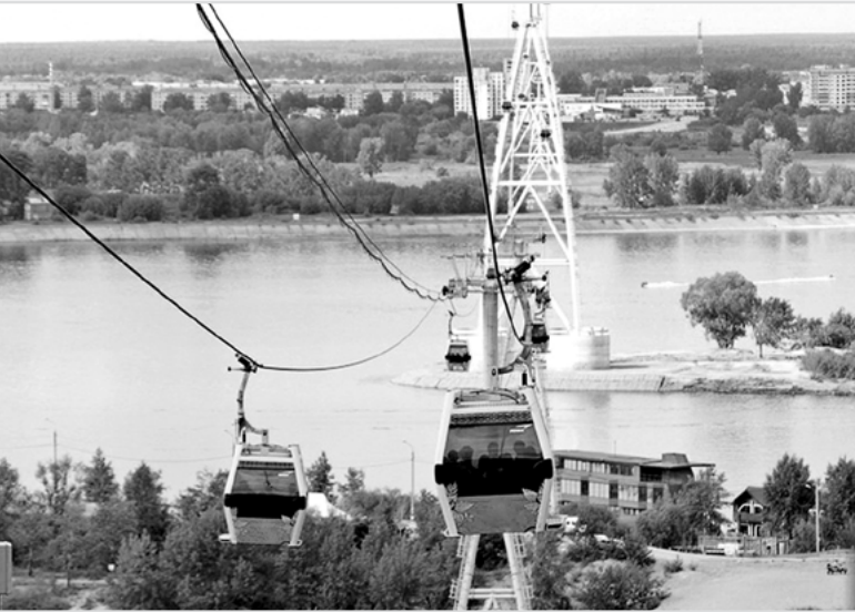
Канатная дорога в Нижнем Новгороде
