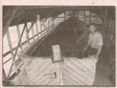
В Ростове спущена на озеро Неро ладья «Княжич Василько», построенная по образцу древнерусских судов. Чертежи судна были сделаны по найденным во время раскопок шпангоутам (поперечным балкам в корпусе судна)
