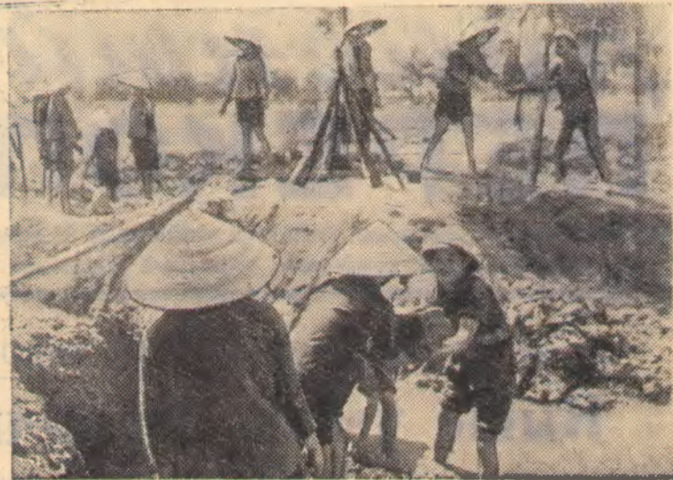
ДРВ. Последствия американских бомбардировок быстро ликвидируются. Крестьяне с помощью бойцов ВНА заделывают повреждения в дамбах и ирригационных сооружениях. Ремонтируются дороги, восстанавливаются мосты и переправы.
